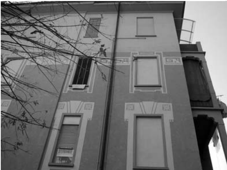
Via Arquata: gli edifici del quartiere dopo gli interventi di recupero 2000-2002.
