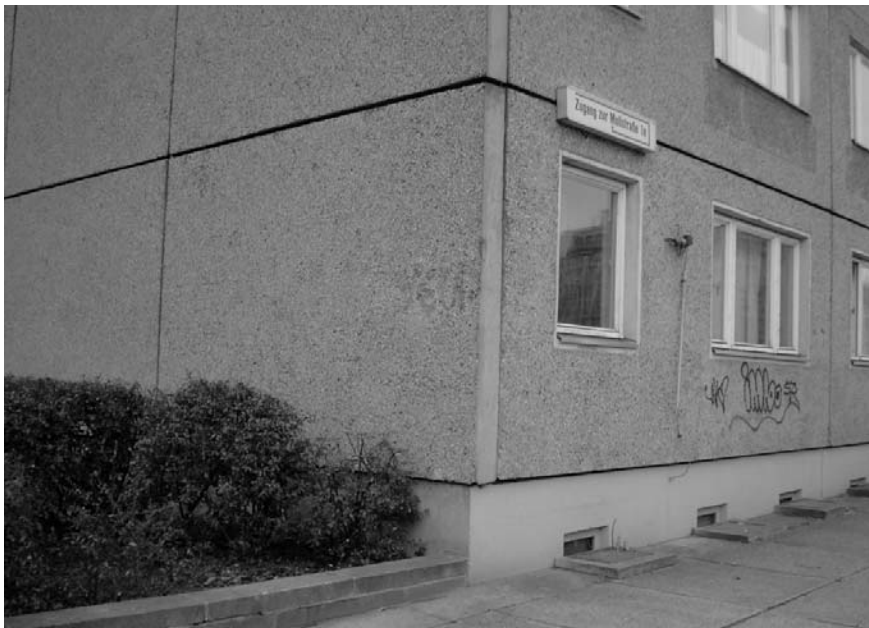
Figura 4. Berlín. Cierre característico de una fachada de viviendas con placas de prefabricación pesada, sin rehabilitar.
