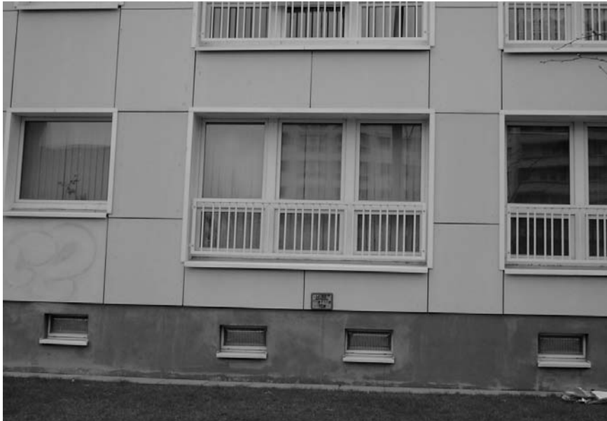
Figura 6. Berlín. La mejora de las viviendas comporta la incorporación de aislantes térmicos, generalmente en el exterior, adosados a la fachada y la mejora de las ventanas.
